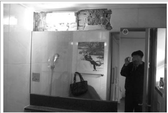
[그림 4] 벽면 상부 타일 해체 후 확인 작업
