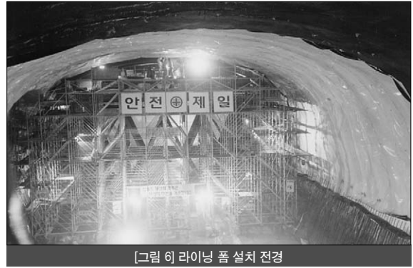
[그림 6] 라이닝 폼 설치 전경
