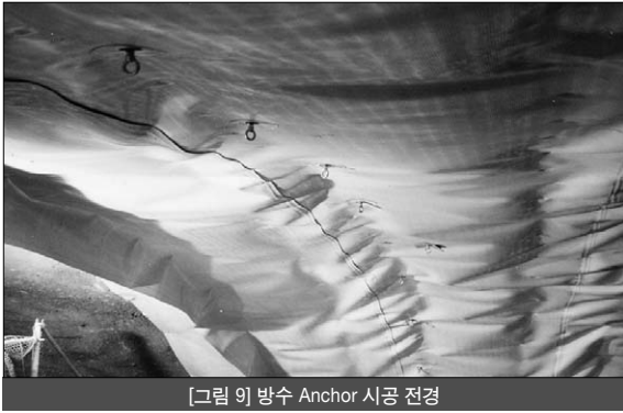
[그림 9] 방수 Anchor 시공 전경
