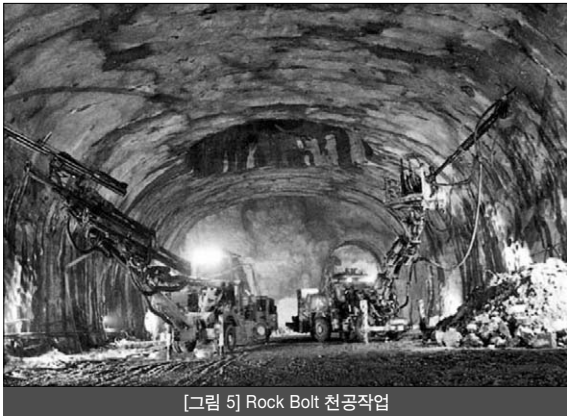
[그림 5] Rock Bolt 천공작업
