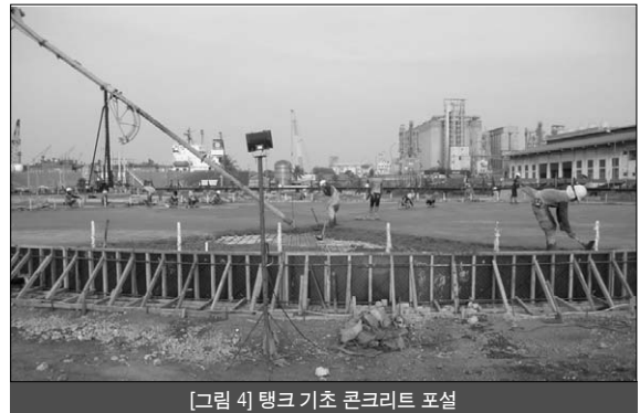
[그림 4] 탱크 기초 콘크리트 포설
