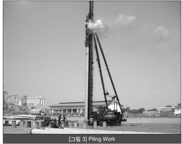
[그림 3] Piling Work
