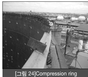
[그림 24] Compression ring
