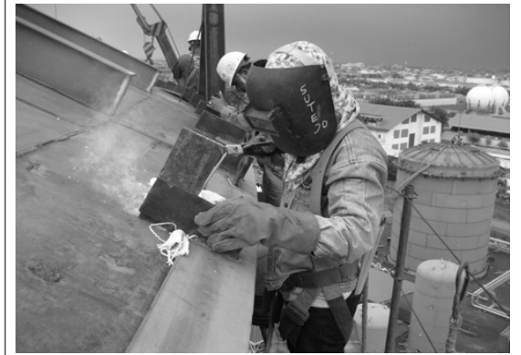
[그림 32] Air Raising 및 지붕판 고정
