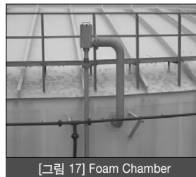
[그림 17] Foam Chamber
