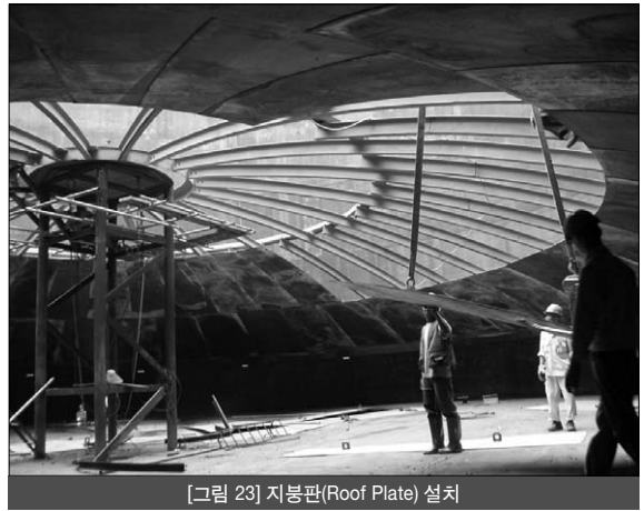
[그림 23] 지붕판(Roof Plate) 설치
