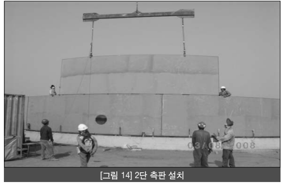
[그림 14] 2단 측판 설치
