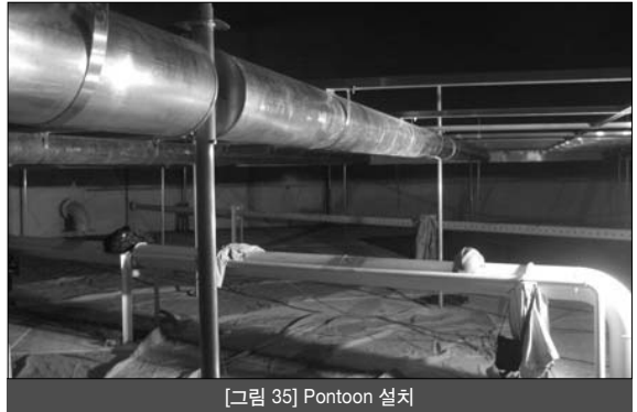
[그림 35] Pontoon 설치
