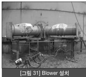
[그림 31] Blower 설치
