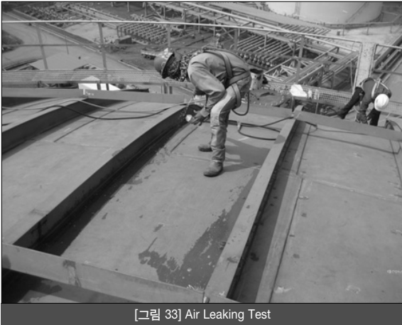
[그림 33] Air Leaking Test
