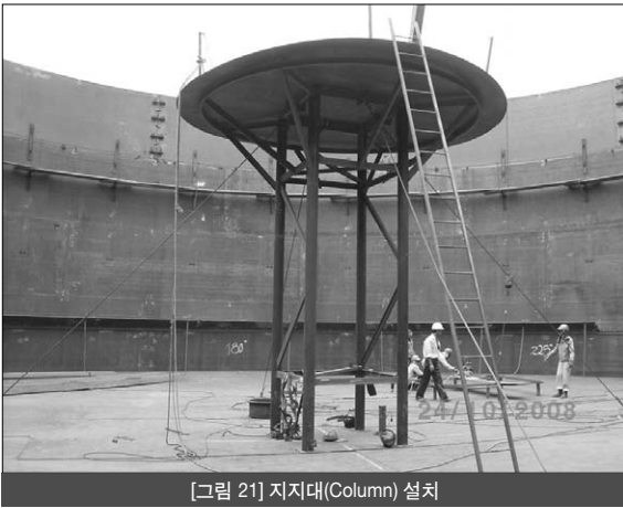
[그림 21] 지지대(Column) 설치
