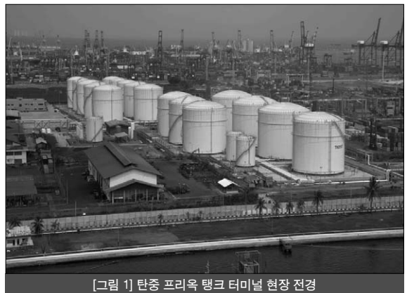
[그림 1] 탄중 프리옥 탱크 터미널 현장 전경
