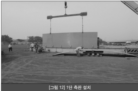
[그림 12] 1단 측판 설치
