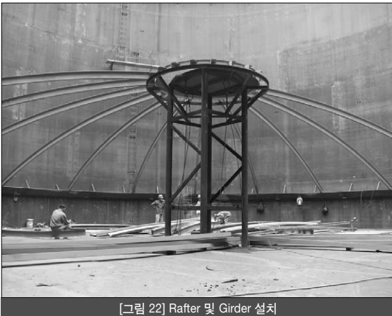
[그림 22] Rafter 및 Girder 설치
