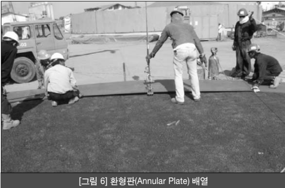
[그림 6] 환형판(Annular Plate) 배열
