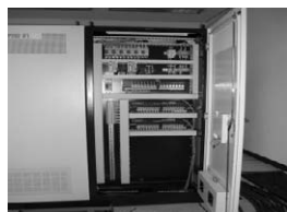
② DCS 패널 설치
