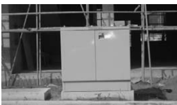
③ Pad TR 설치
