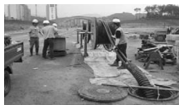
④ Cable Pulling
