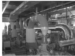
④ DH펌프 등 기기 설치
