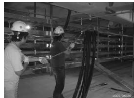
④ Cable Pulling
