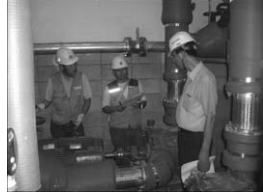
⑥ 소화배관 및 소방펌프 설치
