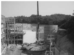
① 축열조 설치공사
