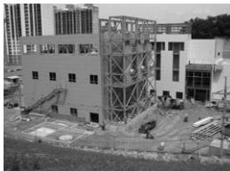
⑦ 내부마감 외벽 패널 설치
