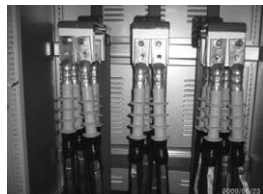
⑥ Cable 단말처리
