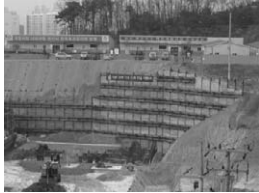
① 흙막이 가시설 공사
