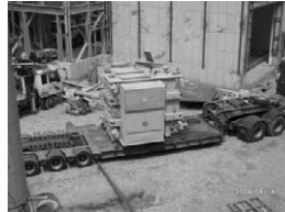
① 주 변압기 설치
