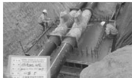
④ Ball V/V 맨홀 설치
