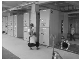
③ 전기실 패널 설치
