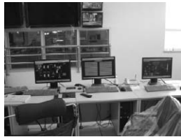
④ DCS O/C 및 T/C 설치
