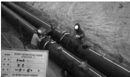
① 열수송관 설치
