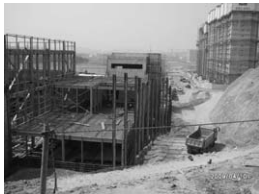
⑥ Deck Plate 설치
