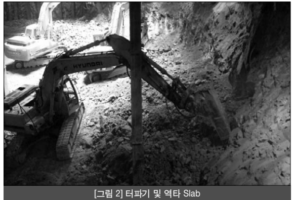
[그림 2] 터파기 및 역타 Slab
