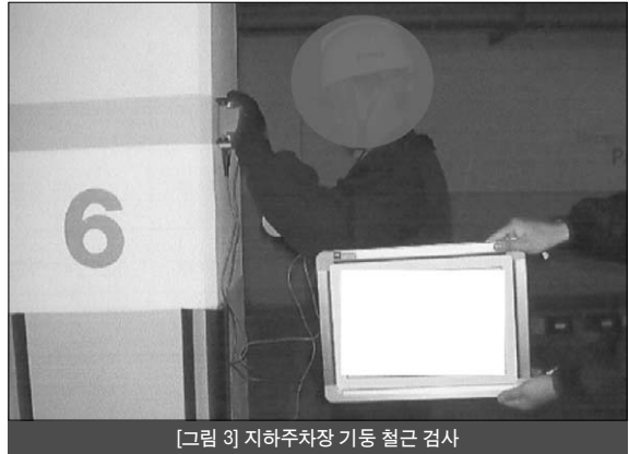
[그림 3] 지하주차장 기둥 철근 검사
