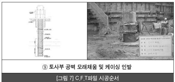
[그림 7] C.F.T파일 시공순서
