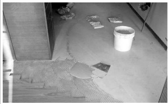
〈그림2〉 합판마루 접착제 도포
