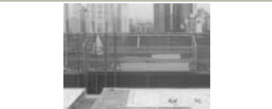
작업중 인접 갱폼과 연결이 단락 될 경우 단부 처리는 <그림 7>와 같이 안전난간대를 추가로 설치하고 C-Channel 상부는 우수유입(부식)방지를 위한 덮개를 설치한다.
