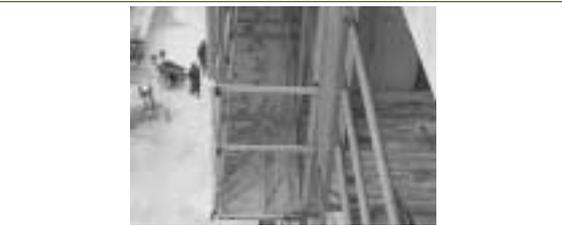
코너부위 및 인접 갱폼발판과의 거리는 작업중 발이 빠지지 않도록 <그림 3>과 같이 20cm이내로 제한하여 설치하고 측벽, 발코니, 계단실 등 인접 갱폼과 Level을 유지토록 한다.
