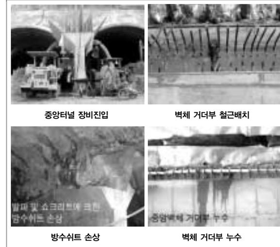
국내 2-Arch 터널 현장을 방문하여 조사한 결과 다음과 같은 문제점을 확인할 수 있었다. 첫째, 안정성 위주의 터널 설계로 인하여 중앙터널 폭이 협소하여 시공장비의 통행이 곤란하며 중앙벽체 거더부 철근 맞이음으로 인하여 배수관 설치시 시공성이 저하
