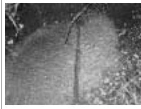
| 그림 6 | 녹화하였을 경우의 콘크리트 (크랙이 거의 없음)
