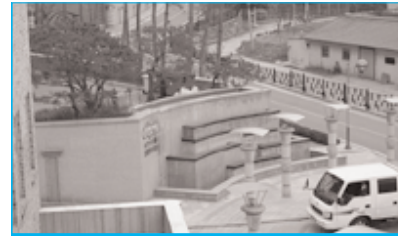
[그림 3] 단지입구부 수경시설 : 보정리 e-편한세상
