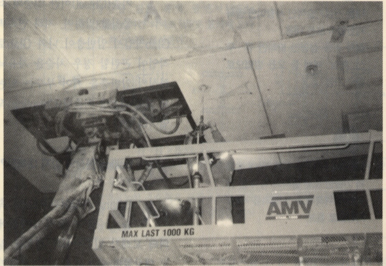
거치된 Sandwich Panel을 Bolting하여 부착하는 광경
