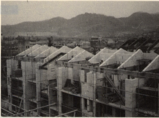
Attic Wall 시공
