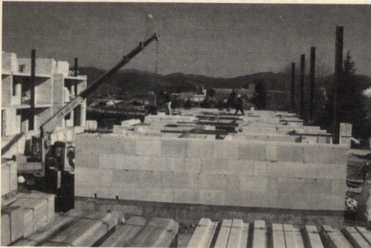
슬라브 패널 설치 준비
