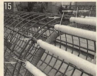
15 설치밴드가 후공정시 방해되지 않도록 설치밴드의 끝부분을 절단한다.
